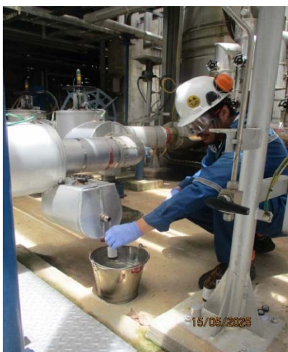
น้ำที่หมุนเวียนในระบบดักจับไอระเหยอะซิโตนด้วยน้ำ ในระบบ Acetone Scrubber Stack D-1904
